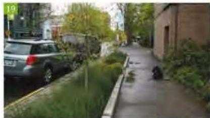
Retención y filtrado de aguas pluviales, Portland
