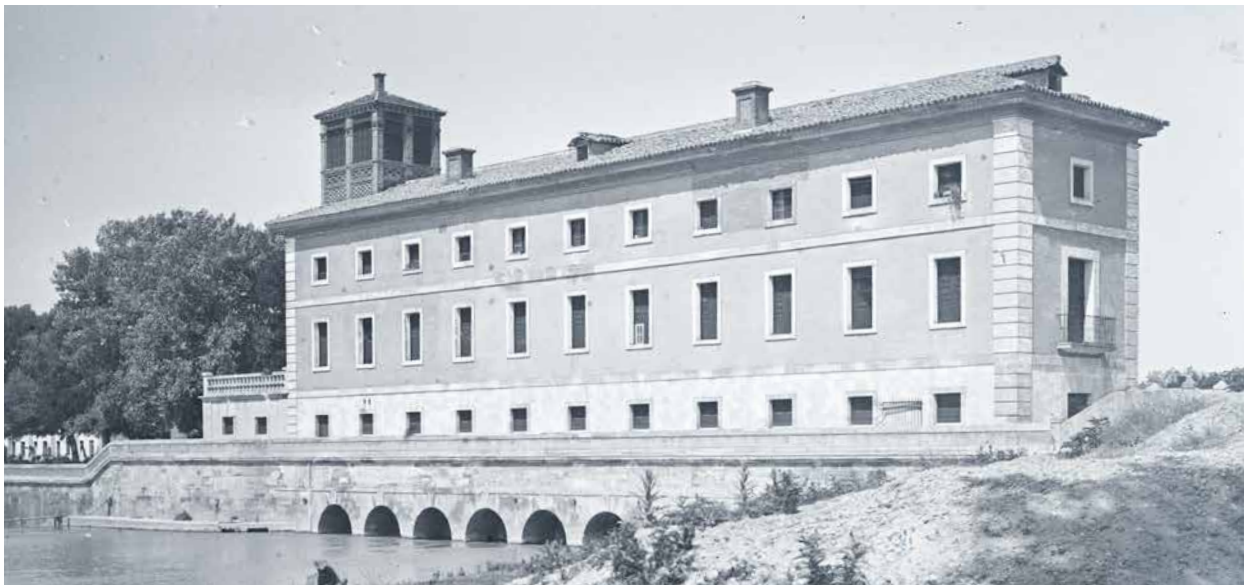
Casa de compuertas del Canal Imperial de Aragón, vista desde aguas arriba. Julio de 1929. Fuente: Archivo CHE.
