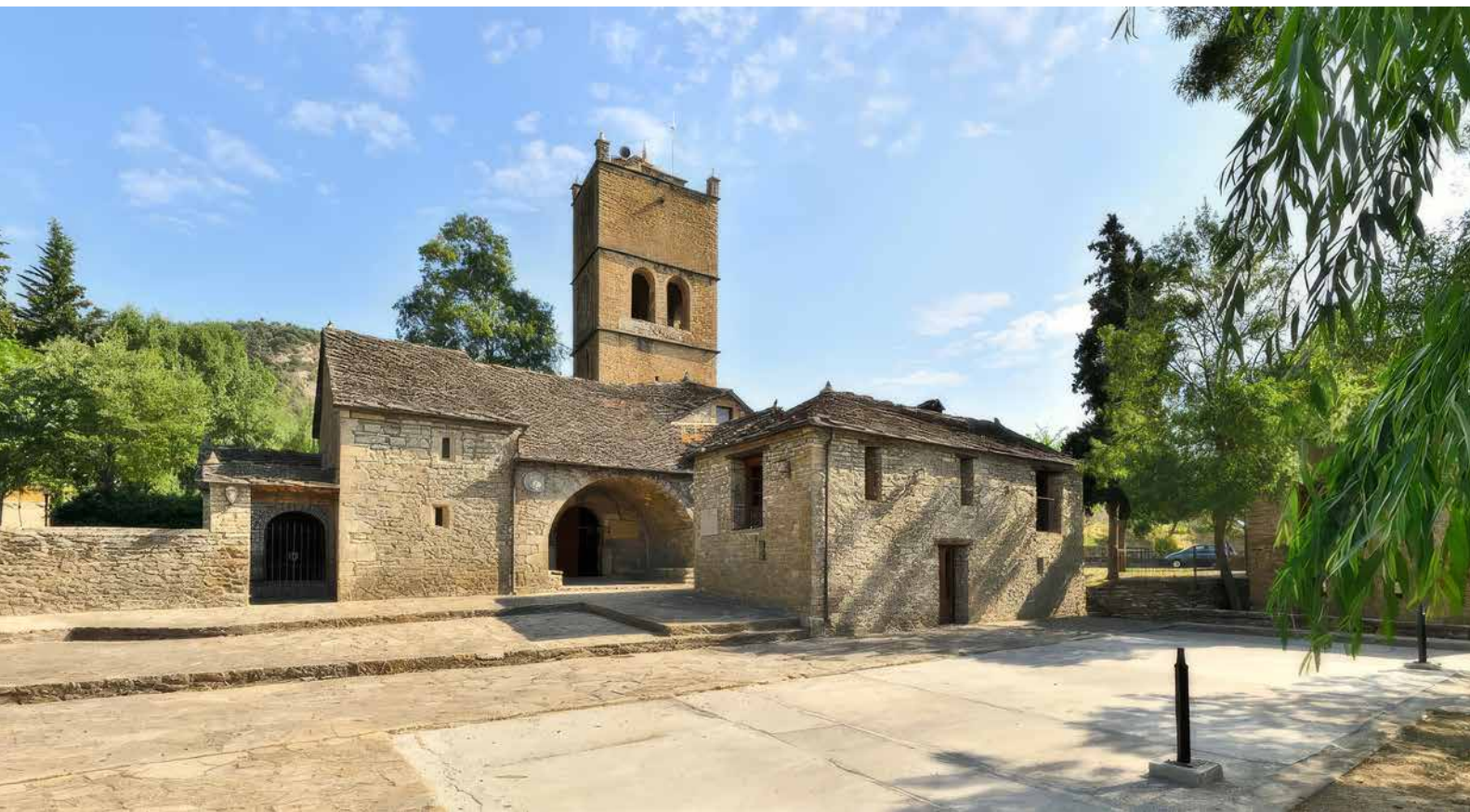
Morillo de Tou. Estado actual. Foto: Sixto Marín.
