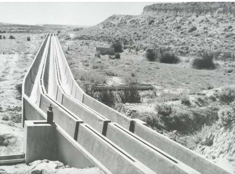
Trabajos de infraestructura hidráulica vinculados al desarrollo de los Riegos del Alto Aragón. Fuente: Archivo CHE.
