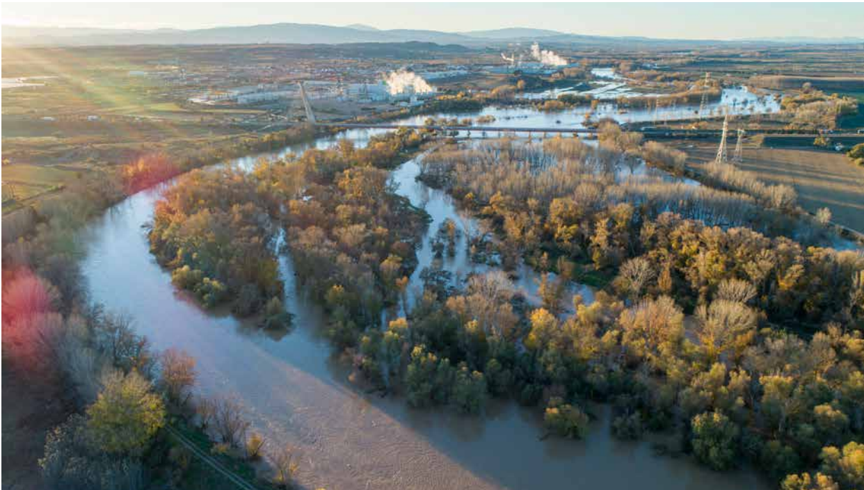
Actuación de curage del cauce del río Ebro en Valtierra (Navarra), enmarcada en el proyecto LIFE Ebro Resilience P1, orientado a mejorar la capacidad hidráulica y reducir el riesgo de inundación. Fuente: Archivo CHE.
