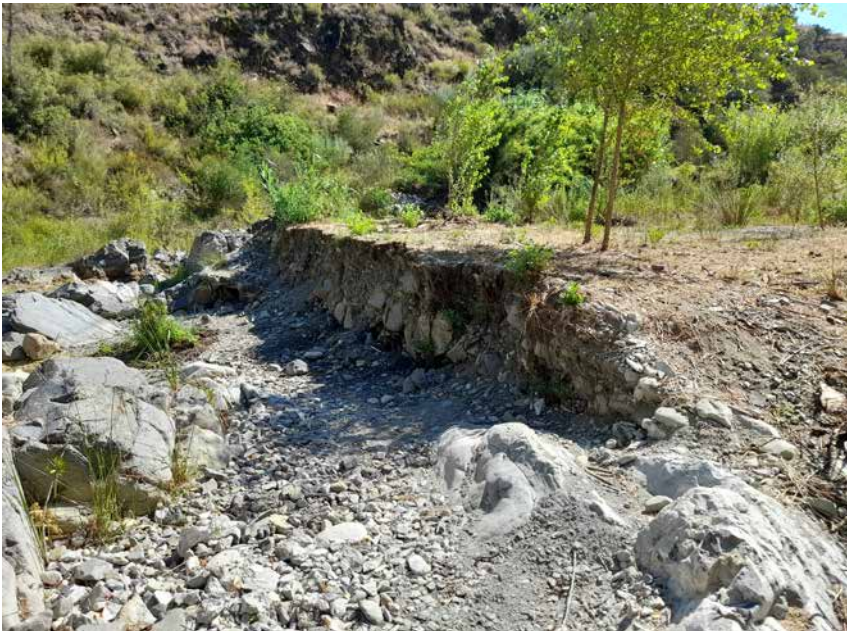
Figura 2. Eliminación de azud en el río Siurana. Ya retirado el obstáculo, se observa el sedimento atrapado, que ha quedado a la espera de ser movilizado por las futuras crecidas. Foto: A. Ollero.
