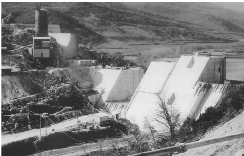
Presa de Eugui en fase de construcción, 1969. Fuente: Archivo CHE.
