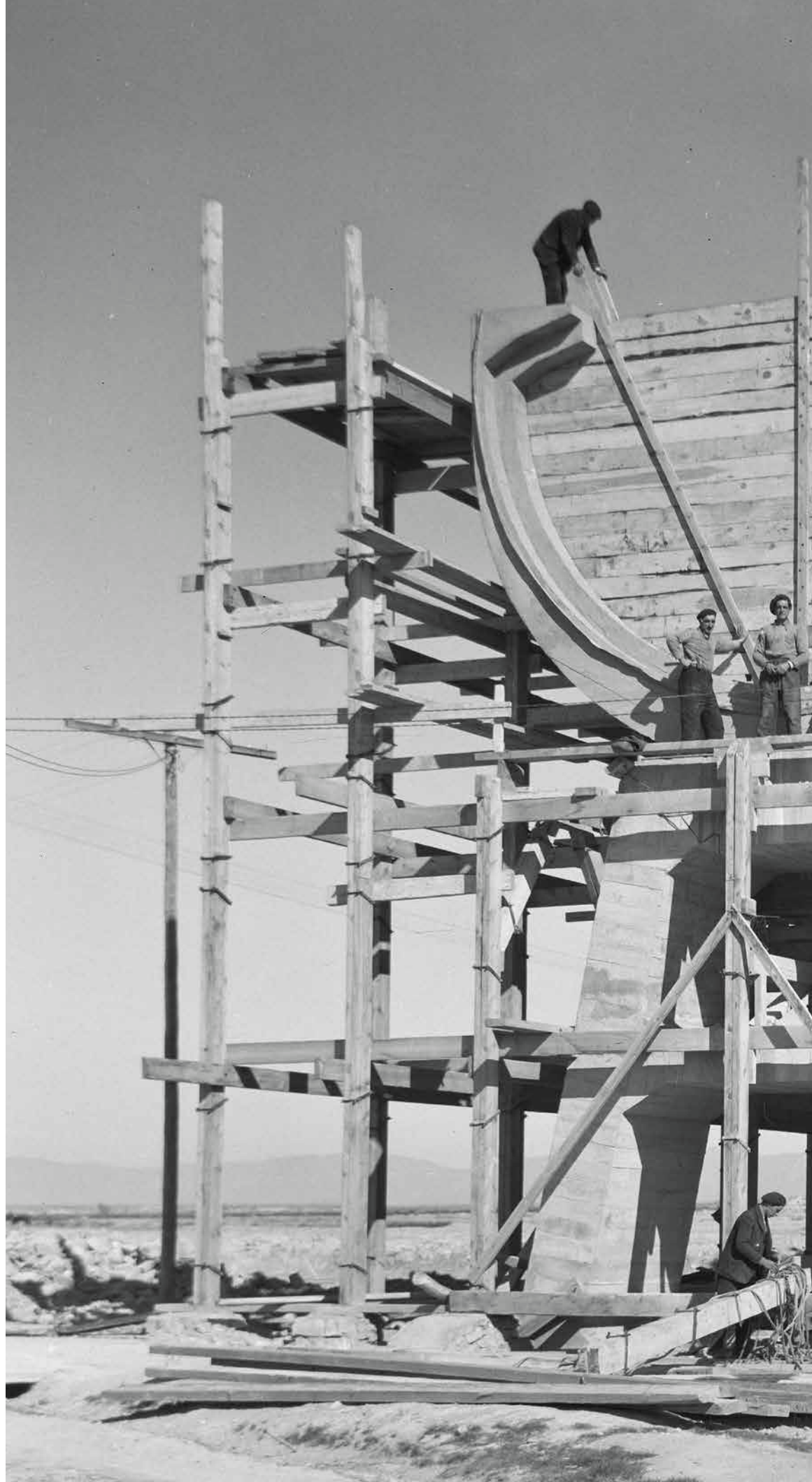
Construcción del acueducto de Tardienta para el canal de Monegros, en 1935. Fuente: Archivo CHE.
