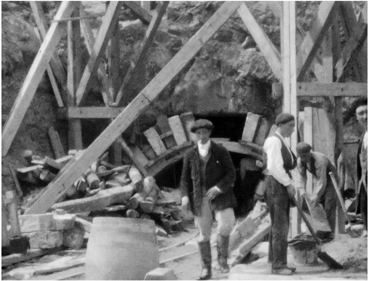
Construcción del embalse del Ebro. Las obras del embalse comenzaron a finales de la década de 1920 y la presa se finalizó en 1946. Fuente: Archivo CHE.
