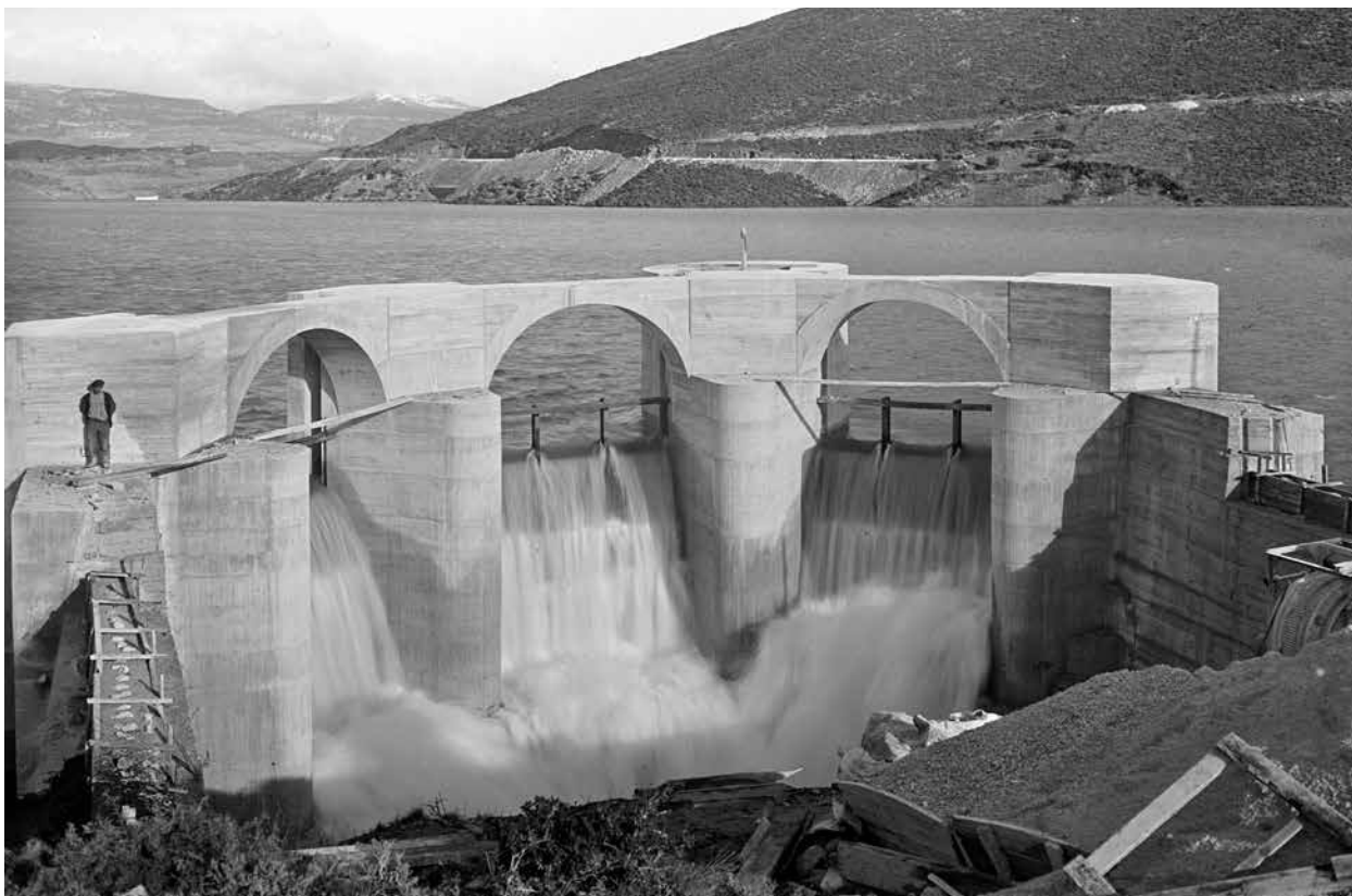
Aliviadero de la presa de Alloz (Navarra), fotografía tomada en diciembre de 1930. Obra hidráulica de regulación en la cuenca del río Salado, destinada a aportar recursos a las áreas regables dominadas por el canal de Alloz y a la producción hidroeléctrica a pie de presa. Fuente: Archivo CHE.
