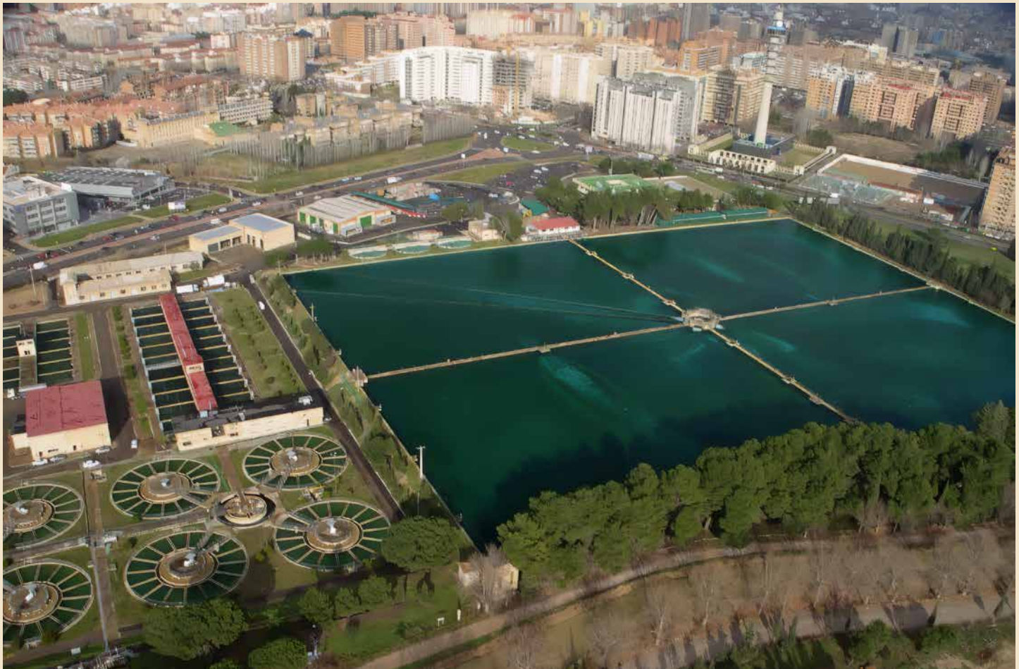
Zona de abastecimiento de agua potable de Zaragoza y su entorno metropolitano. Fuente: Archivo CHE.
