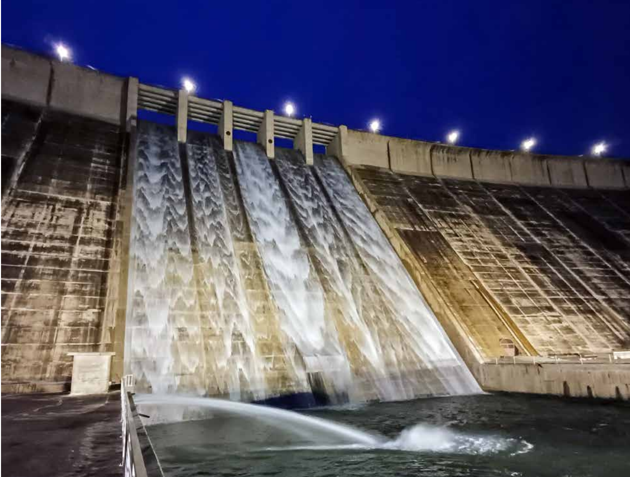
Primer llenado de la Presa de Montearagón, en 2026. Foto: Víctor M. Benedet.
