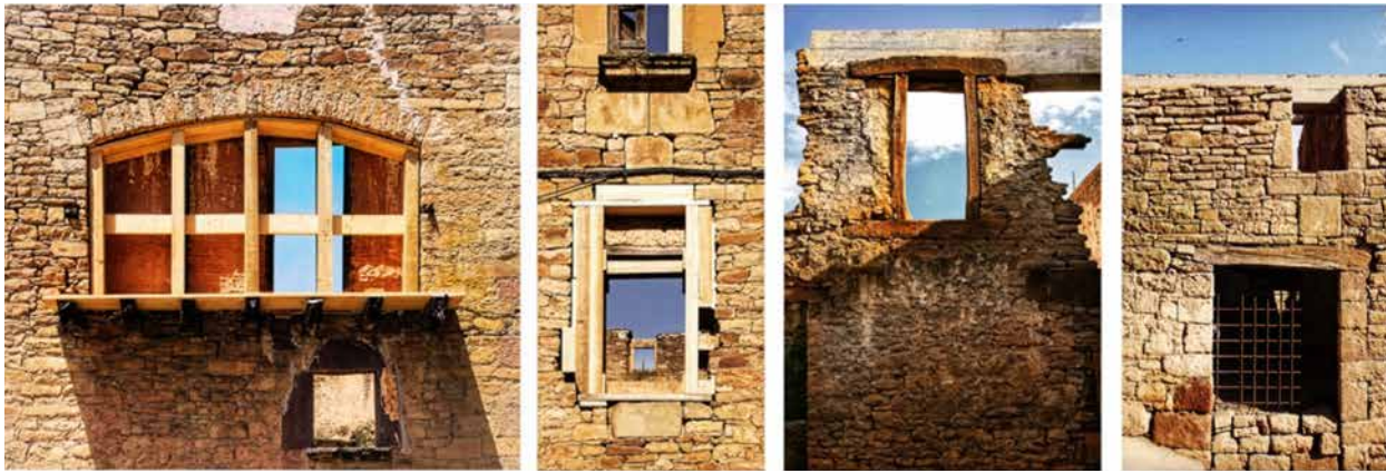
Intervenciones de consolidación en la calle del Centro y Camino de Santiago (Ruesta). Foto: Sebastián Arquitectos.
