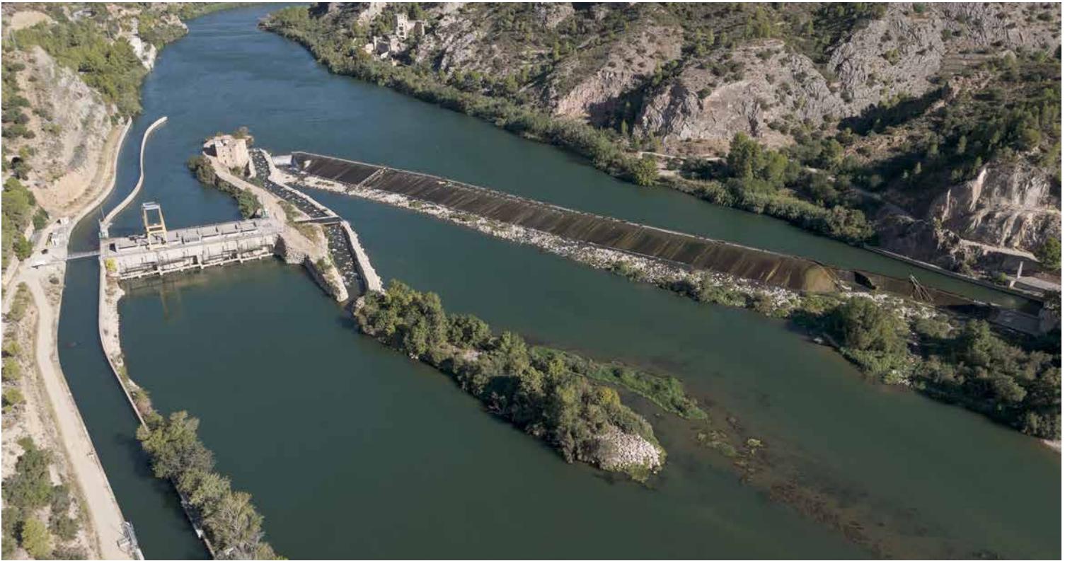
Vista aérea del azud de Xerta, obra hidráulica de origen andalusí (siglos X-XI), reformada en época moderna para la derivación de caudales del río Ebro. Foto: Al Este Films.
