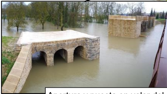
Apertura y puesta en valor del puente antiguo de Abetxuko
