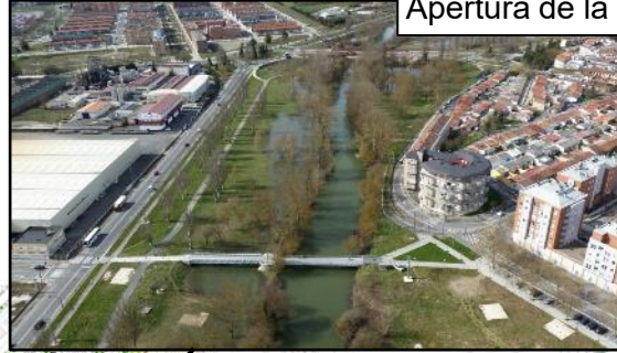
Apertura de la pasarela de Abetxuko
